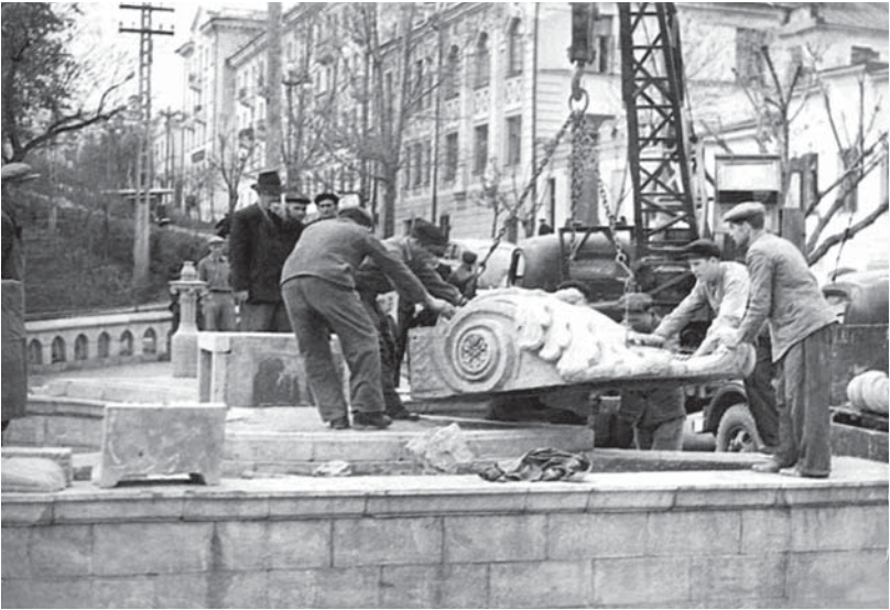
Установка элементов основания фонтана-грота на бульварной части проспекта им. Сталина (сегодня - пр-т К. Маркса), 1957 г. Б. Будкевич на снимке слева (в шляпе).
