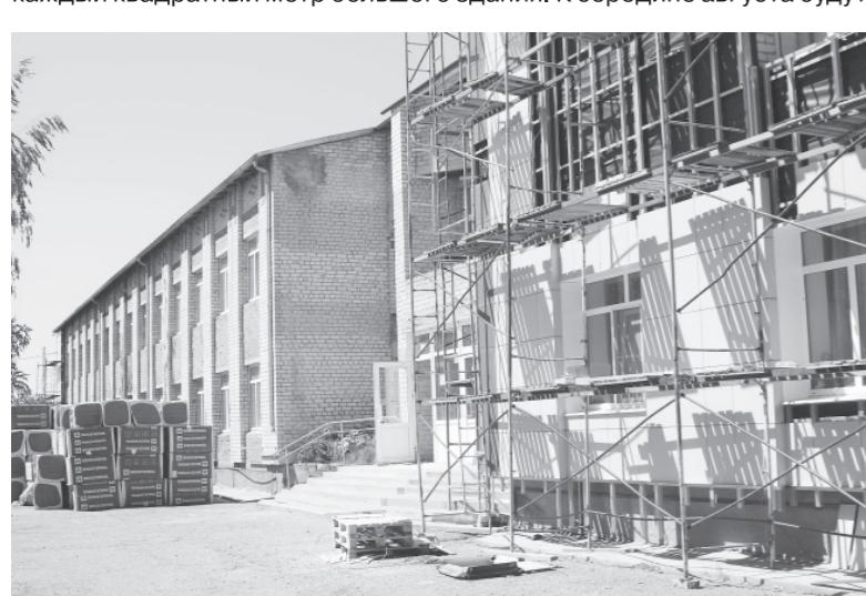
полностью заменены системы электроосвещения, отопления, водоснабжения, канализации, противопожарной сигнализации, в корпусе установят новые окна, двери. Уже сейчас часть обновленного фасада облицована керамогранитом. Обустройство вентилируемого покрытия гарантирует комфортные условия во внутренних помещениях в любое время года. На проведение ремонта из бюджетов всех уровней выделено более 74 миллионов рублей.
