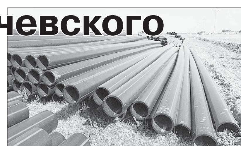
для их укладки роторным экскаватором будет выкопана траншея. На двухкилометровом участке, где давление воды более высокое, будут стальные трубы. Работы ведутся одновременно на обоих участках. Вододобор находится в селе Ключевском Труновского района, его питают многочисленные родники. От рабочего графика не отклоняемся. Чтобы гарантирован-
