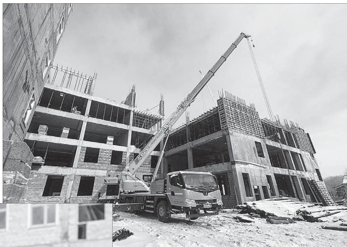
**МОНOLИТНЫЕ** работы на объекте выполнены уже на 70%. Начаты монтаж внутренних инженерных сетей, установка окон. Отделочные работы должны стартовать в марте.
