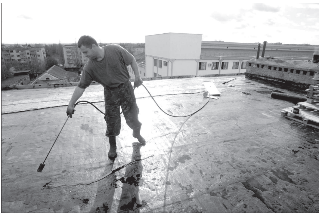
● При ремонте жилищного фонда основной упор делается на самые «больные» места: ремонт кровли, подвалов и фасадов, замену лифтов и инженерных сетей.
