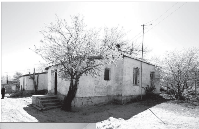
● В крае более четырехсот многоквартирных домов были признаны аварийными.
