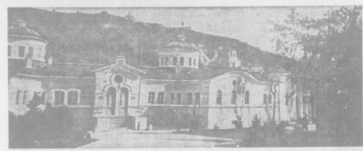
Здание Ермоловских ванн в Пятигорске, построенное 100 с лишним лет назад. Фото В. Зильберг.
